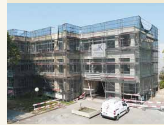
Teilsanierung Schulhaus Rain I © 2020 Claudia Hess
